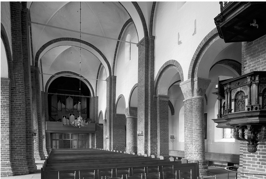
6. Stützenwechsel in de romaanse bakstenen kloosterkerk te Bad Segeberg (Duitsland). [foto Justin Kroesen en Regnerus Steensma]
