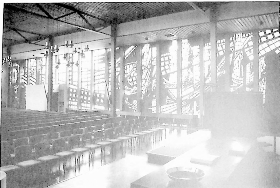
4. HEEMSTEDE, Pinksterkerk, 1957. Glas-in-betonwand met het pinksterverhaal
