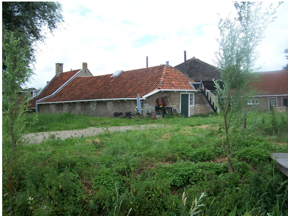
De laatst overgebleven 'Oud-Friese greidboerderij', bij Wartena. Kenmerkende details zijn de lage gootlijn, het geknikte profiel van het dak, de houten dakgoot en de ramen die op een 'vak' afstand van elkaar in de muur zitten. Een 'vak' was een afstand van ongeveer twee meter en werd gevormd door de ruimte tussen de gebinten. In een vak stonden in de winter twee koeien, met de koppen naar de muur. Kenmerkend is ook de losse hooiberg met kap. Uit een boekhouding is bekend dat de rijke boer Hemmema uit Hitzum in 1570 een hooiberg met kap neerzette. De (schaarse) afbeeldingen uit die tijd geven enkel nog hooibergen zonder kap te zien. Hemmema was op dit gebied daarom wellicht een vernieuwer.
