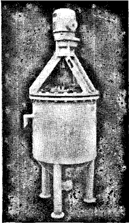
Pilot kristallisator voor zout- zuurmilieu, vervaardigd van staal, eboniet en plastic
