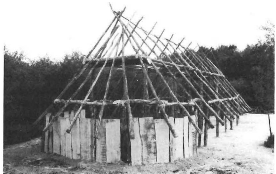
Fig. 2. Een opname tijdens de bouw van het bronstijdhuis in Bargercompascuum.
