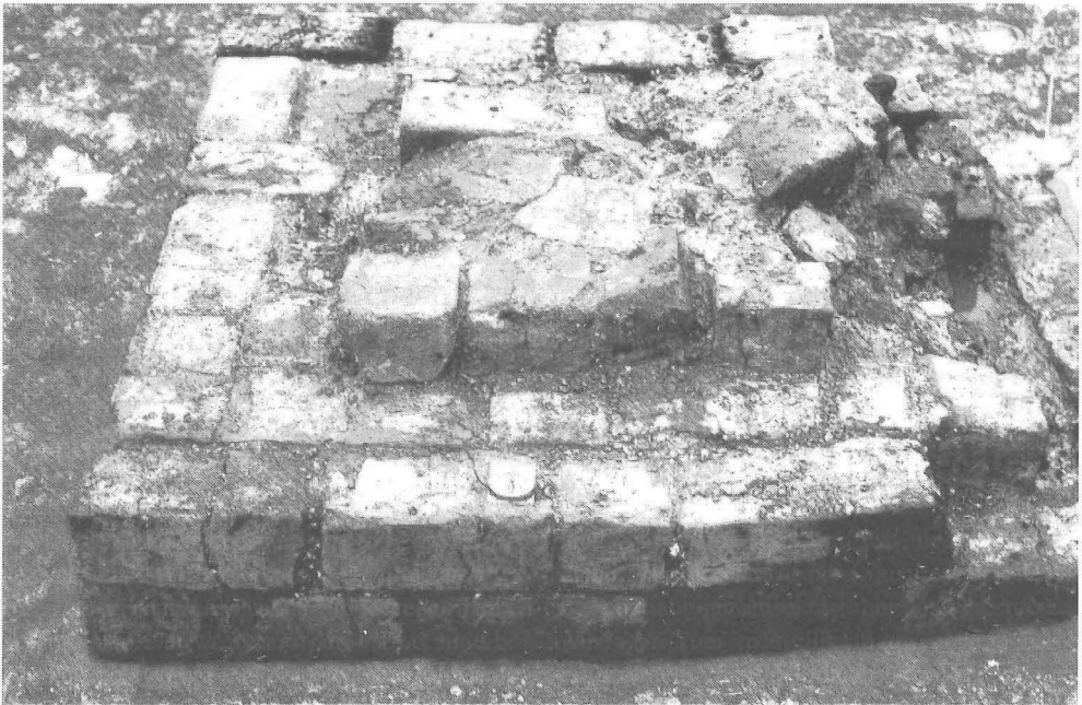
Fig. 3. Een stiep van baksteen vormt een der zes 'pijlers' waarop het steenhuis was gebouwd (foto Provincie Groningen).
