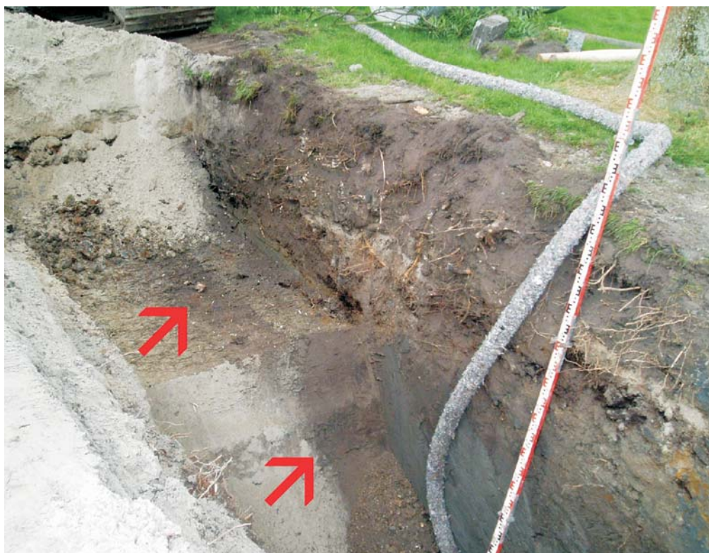
Fig. 3. De graafwerkzaamheden bij de afbuiging van het riool van de Rijksweg in de richting van het Damsterdiep. Halverwege de gegraven rioolsleuf is in de lengterichting van de sleuf de grachtinsteek zichtbaar (een humeuze vulling). De vulling van de dichtgegooide gracht is ook verticaal in de sleuf te zien (foto C. Tulp, De Steekproef).
