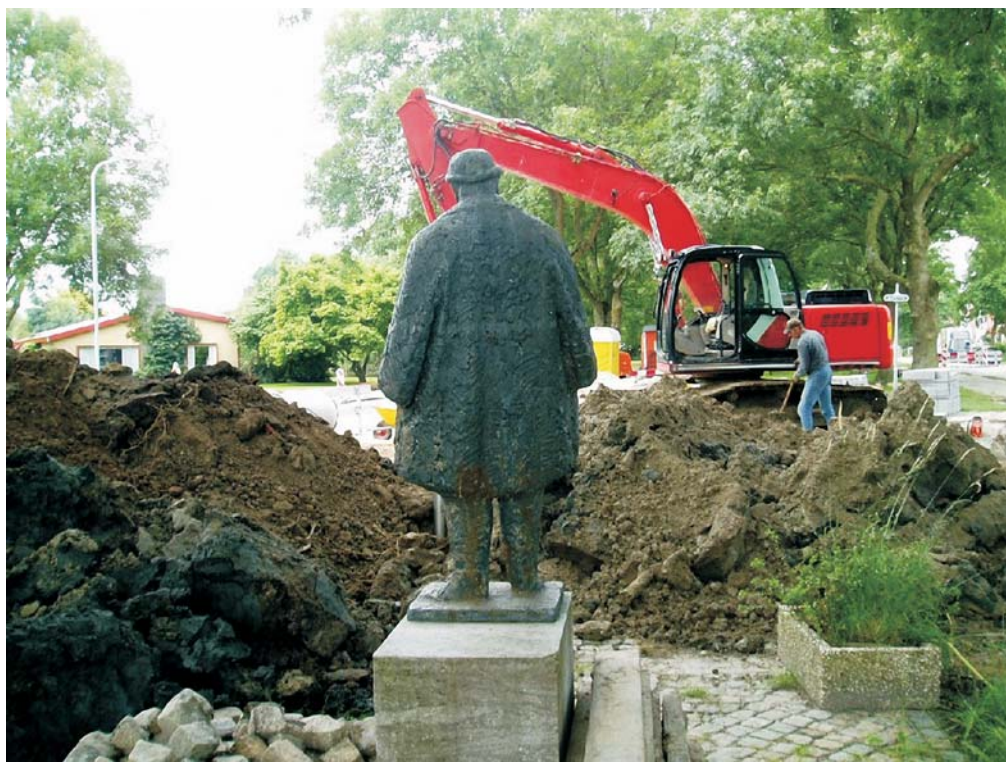
Fig. 2. Overzicht van het riooltracé. Rechts is een deel van de Rijksweg zichtbaar en links het plantsoen waar naast de weg het reliëf van de dichtgegooide gracht nog aan het oppervlak zichtbaar was (foto C. Tulp, De Steekproef).
