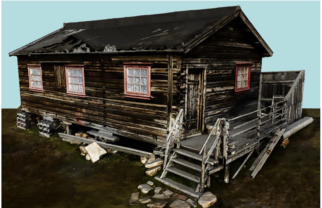
Fig. 4. Afbeelding van een 3D-model van één van de door middel van fotogrammetrie gedocumenteerde gebouwen te Hiorthhamn, oorspronkelijk gebouwd te Advent City (Gary Nobles, RUG/GIA).
