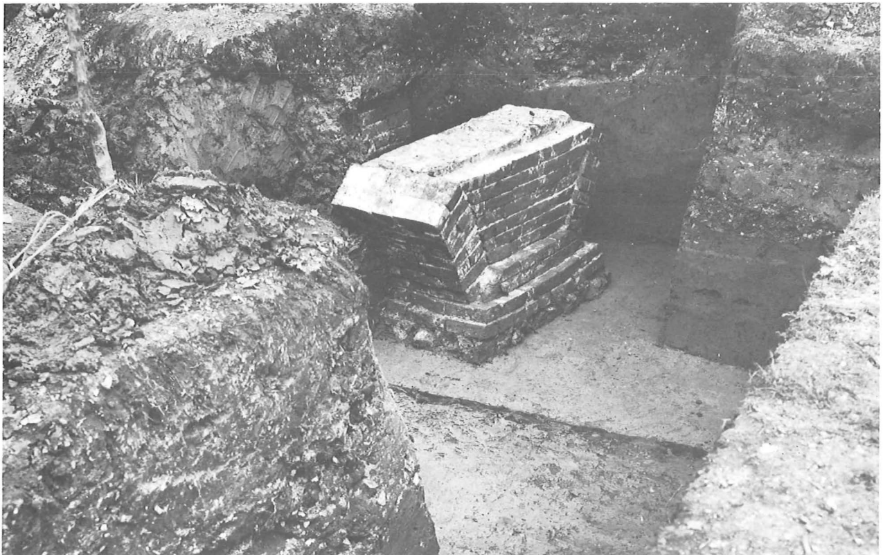
Abb. 16. St. Bernardusabtei Aduard. Pfeiler der Blendarkade im Westen des nördlichen Kreuzgangtraktes. Blick von Südwesten.
