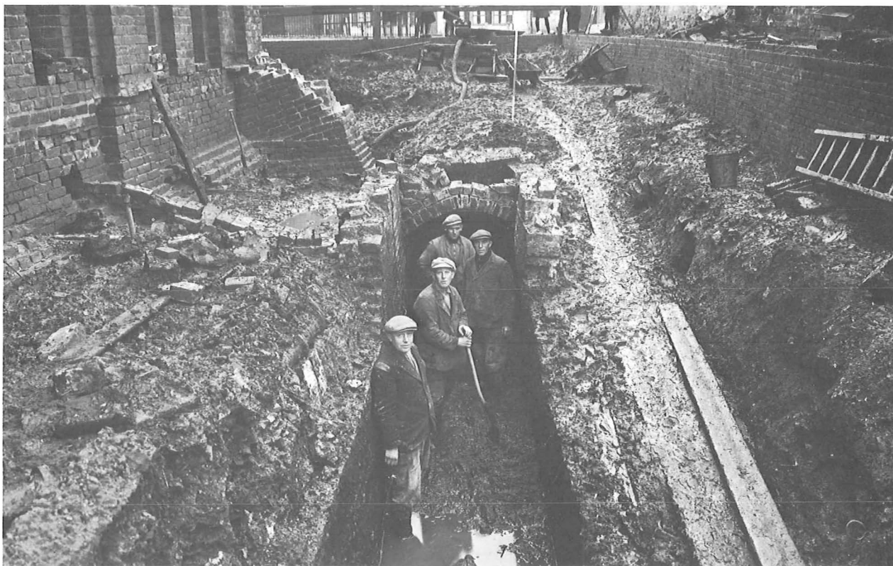
Abb. 17. St. Bernardusabtei Aduard. Abzugskanal am Nordgiebel der Reformierten Kirche entlang. Blick nach Westen.
