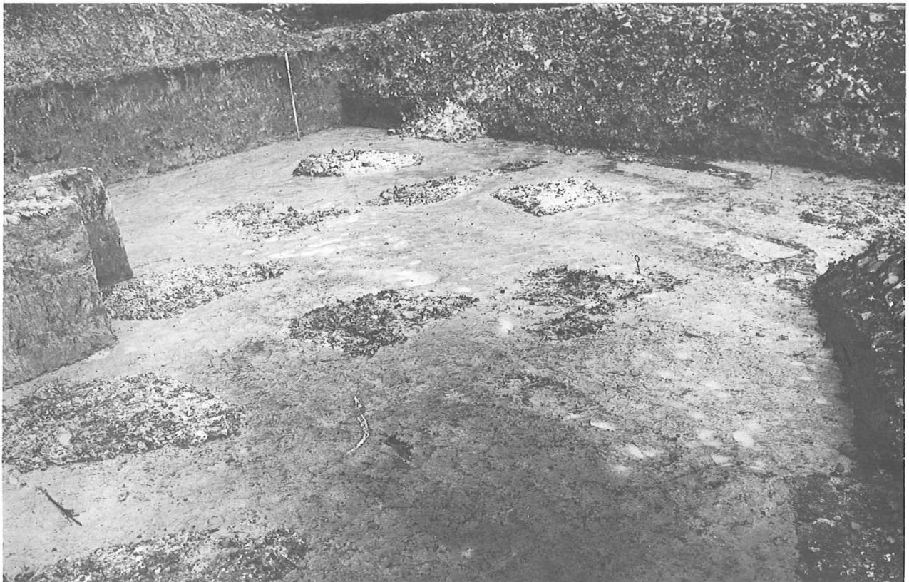
Abb. 12. St. Bernardusabtei Aduard. Pfeiler der Fundamentbogen im Kapellenkranz von Nordwesten. Rechts oben Gräber der Abteikirche I.
