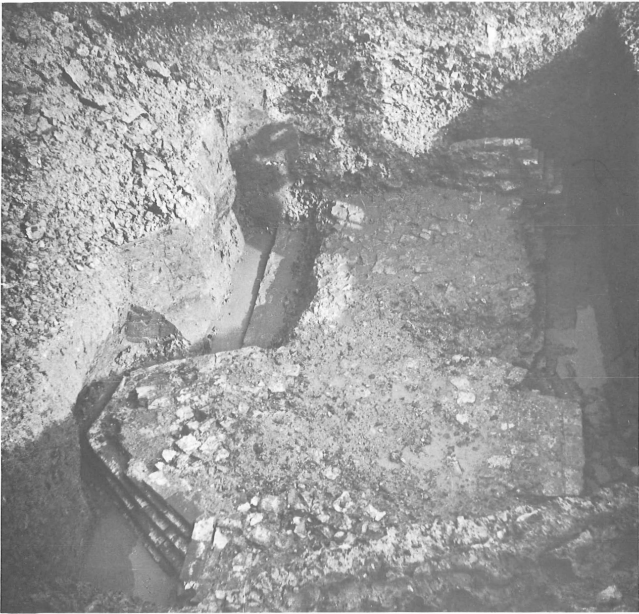
Abb. 10. St. Bernardusabtei Aduard. Südliche Querhausfront mit Wandpfeiler von Westen.
